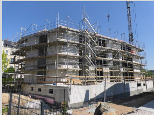
Solardomizil I: Rohbau (Stand: Juni 2017)
