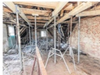
Das Dach des alten Sporthotels ist fast komplett gesichert.
