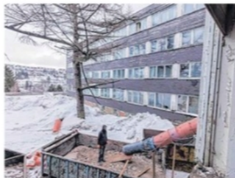
Auch das Beräumen des benachbarten Bettenhauses läuft.
